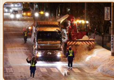
道路の除排雪作業
