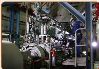
下水道処理設備の点検
