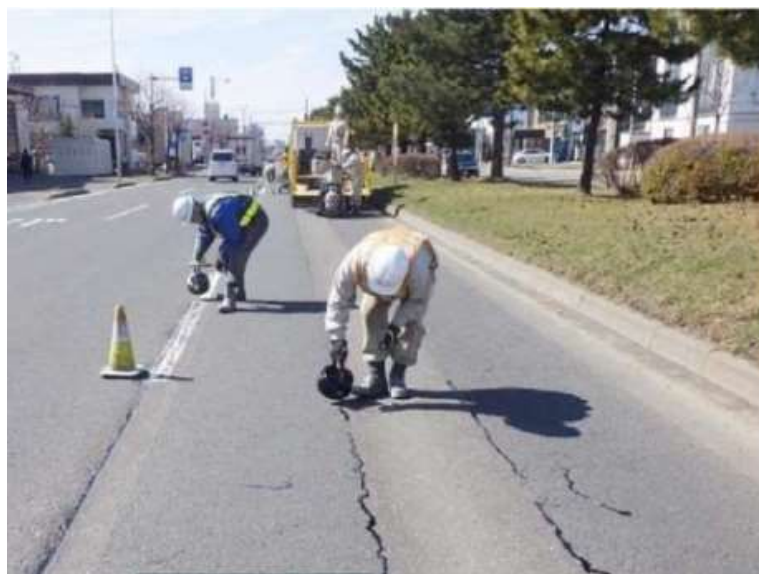
写真 13.1 シール材の充填
