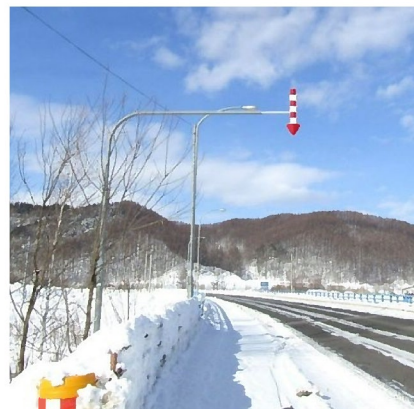
固定式視線誘導柱
