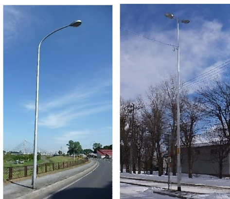
道路照明施設
