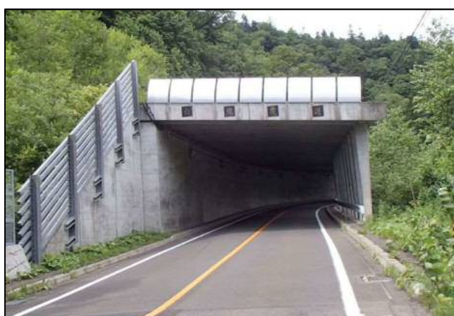
写真 2-2 覆道 (スノーシェッド)
