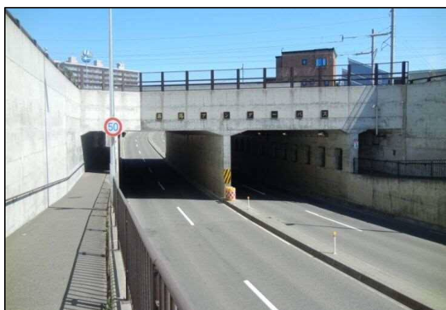
写真 2-1 道路横断施設 (アンダーパス)
