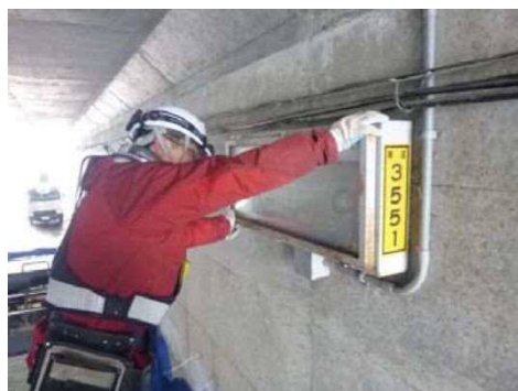
写真 5-1 近接目視による点検状況（左）、触診による取付確認状況（右）
