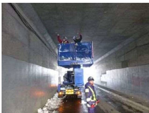
写真 5-1 近接目視による点検状況（左）、触診による取付確認状況（右）
