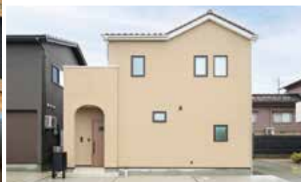
レナガスを使った住宅の施工事例。長くキレイな状態を保てる
