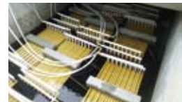
コンクリートの槽の中に排水を流し、プラスチックの熱交換器を入れ、温めているところ
