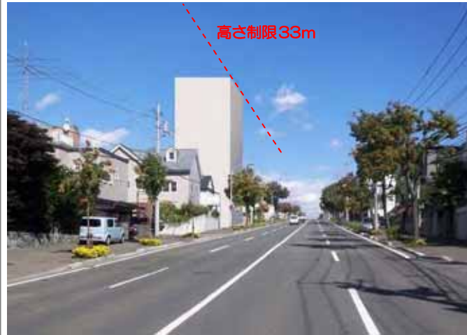
郊外住宅地の幹線道路沿道における高層建築物の立地イメージ
