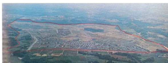
写真 2.1 もみじ台団地造成中航空写真（昭和49年）
