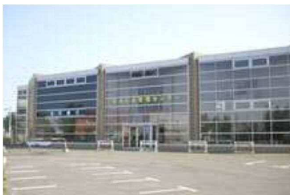
写真 2.3 もみじ台管理センター外観
