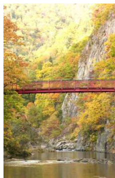
2位 定山溪温泉の二見吊橋 (南区) 19票
