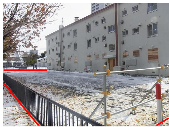
写真②：西側道路より計画地を南東に望む
