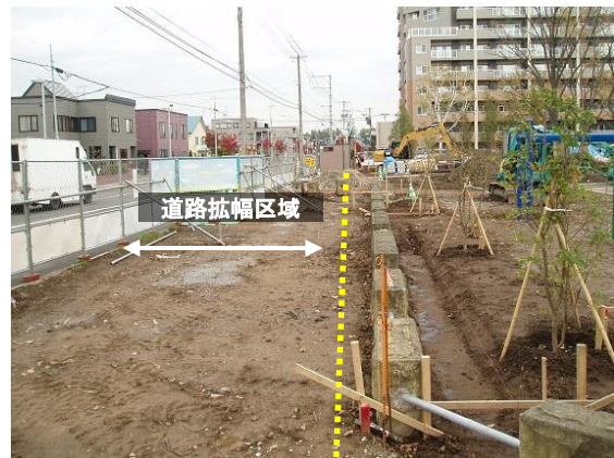
写真右：施工中
