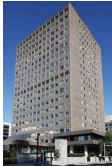
【図9 再生可能エネルギー100%電力を導入している市役所本庁舎】
