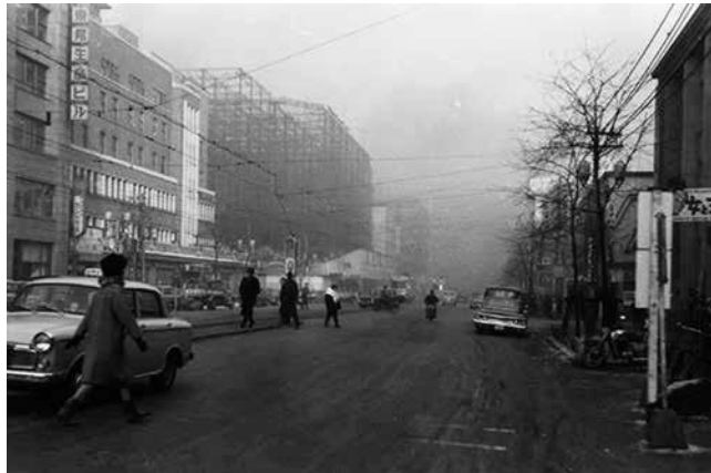
出典：国土交通省北海道開発局 札幌開発建設部 HP 図3 1961(昭和36)年当時の札幌の空
