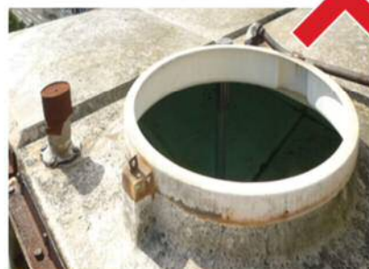
マンホールが破損し開放状態
