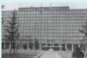
道庁新庁舎完成 (昭43.2) 開道100年にあわせて建てられ、ホレンガ庁舎(日本庁舎)も復元・保存されることになりました。
