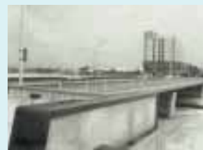
豊平橋新橋改築完成 (昭41.10) 完成した橋は23代目になり、総工費は3億6千万円で、橋脚に鉄筋コンクリートを使用した道内初の橋です。
