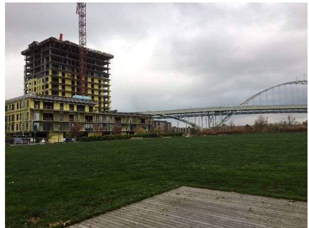
ドッグランのあるザ・フィールズパークと 再開発による新規ビル建築
