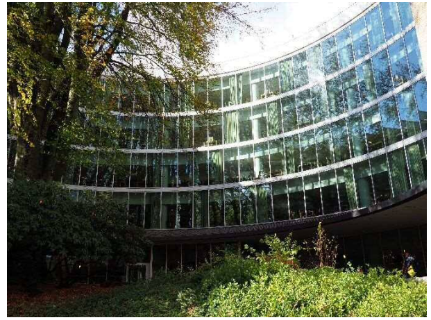
既存の木を生かして設計されたキャンパス建物
