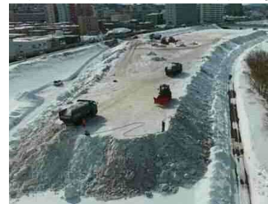
豊平川河川敷地を活用した雪堆積場
