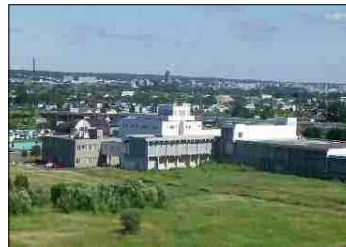
東部水再生プラザ
