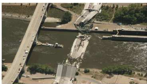
写真1 橋梁崩落事故の状況
