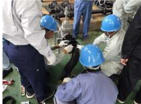
上水道の配管実習の様子 JICA 課題別研修「上水道施設技術総合(B)」
