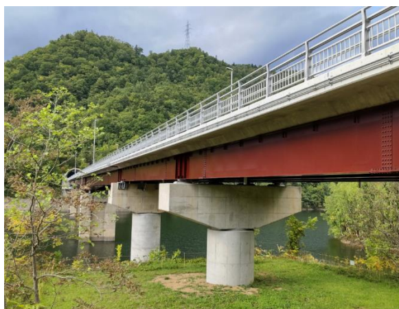
写真：耐震化工事完了後（滝の沢大橋）
