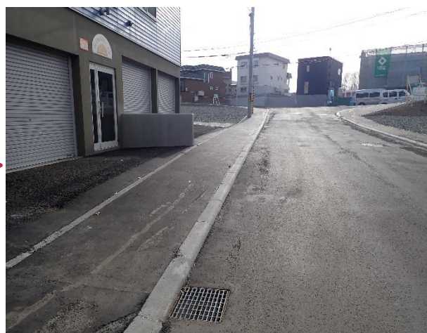
写真：復旧工事後の様子（左写真と同じ地点）
