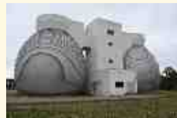
消化槽 (岩見沢市 南光園処理場)
