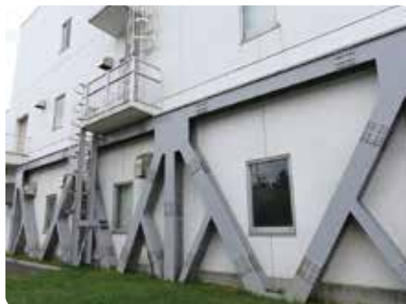
揚水施設の耐震化(外部補強)
