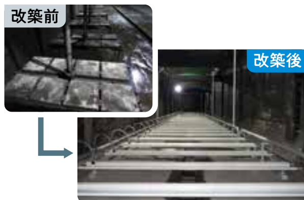
劣化により機能が低下した散気装置の改築
