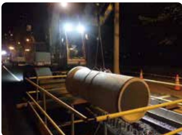
管路の耐震化(管の入れ替え)
