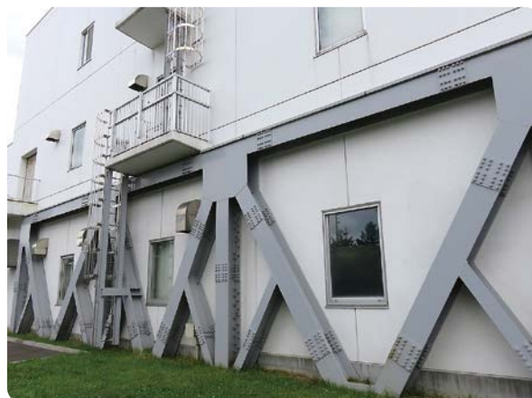
揚水施設の耐震化(外部補強)
