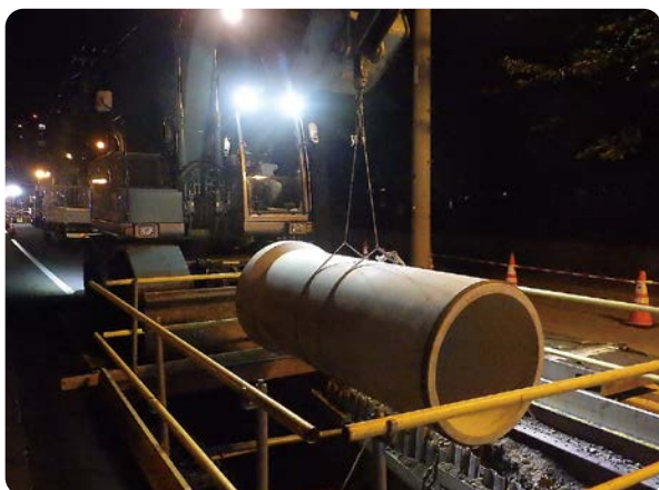
管路の耐震化(管の入れ替え)
