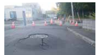
埋設状況を踏まえた管路の耐震化 (参考:液状化の状況)
