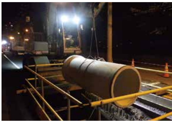
緊急輸送道路に埋設された管路の耐震化
