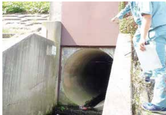
災害対応訓練(施設の緊急点検)
