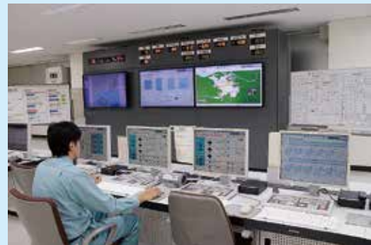
処理施設の運転管理
