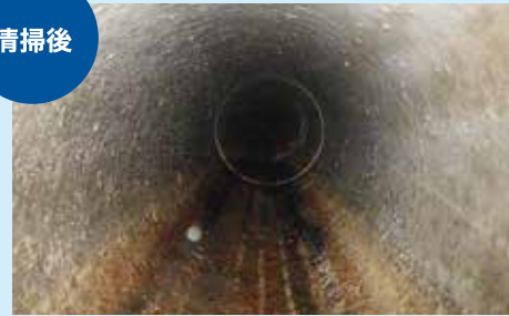
管路の清掃 (管内の沈殿物の吸引作業)
