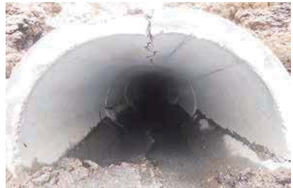
管路の老朽化の状況（上部に亀裂の入った管路）
