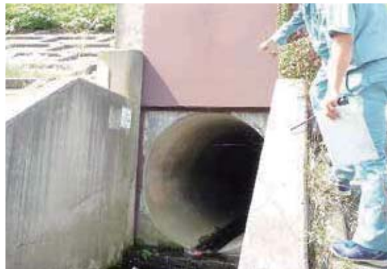
災害対応訓練(施設の緊急点検)
