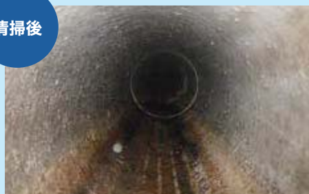
管路の清掃 (管内の沈殿物の吸引作業)
