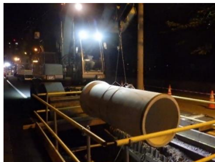
管路の耐震化（管路の入れ替え）
