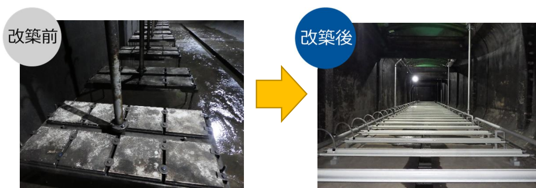
機械設備の改築（散気装置）
