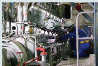
点検・調査と修繕
