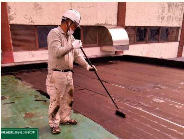
屋上の防水シートの修繕
