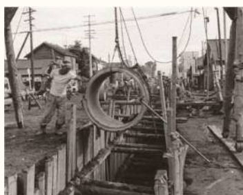
下水道の建設当初
