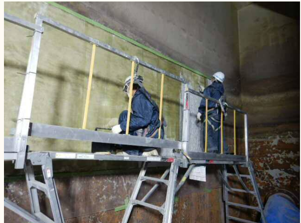
水槽の防食塗装の修繕
