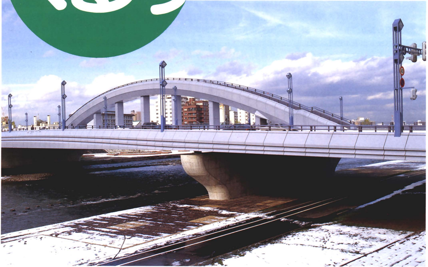
みごとにリニューアルした幌平橋（ポートランド広場） 橋の中にあるアーチ型の遊歩道がひととき目立ちます。—10月10日 開通—
