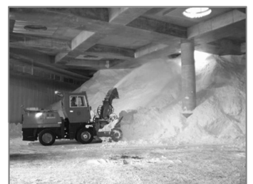
モエレ沼公園の 雪冷房貯雪庫
